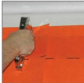
2. Installez des agrafes SS à 2 po de la partie supérieure, au-dessus du ruban intégré. Évitez d'agrafer la zone du ruban.
