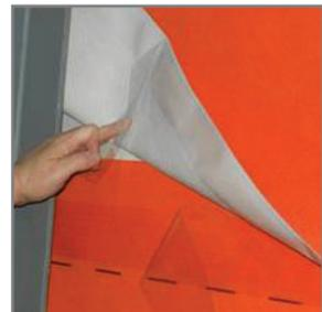
8. Commencez à joindre les jointures horizontales en enlevant les deux papiers de protection (la partie inférieure de la bande supérieure de recouvrement et la partie supérieure de la bande inférieure).
