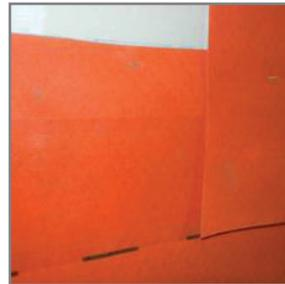
3. Alignez la partie inférieure de la bande supérieure du matériau avec la ligne en pointillée pour créer d'un chevauchement de 6 po.
