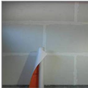
1. Commencez l'installation à la base du mur en continuant vers le haut et sous forme de chevauchements.
