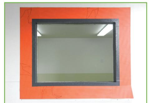
*El uso de VaproLiqui-Flash simplifica el proceso de impermeabilizar detalles en construcciones nuevas o existentes.*
