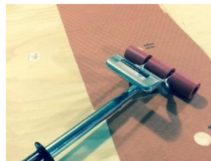
Figure 1 , Hand roller to firmly affix the WrapShield SA membrane.
